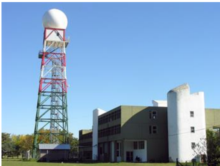
Fig. 7.3.2 – Radar del INTA en Pergamino
