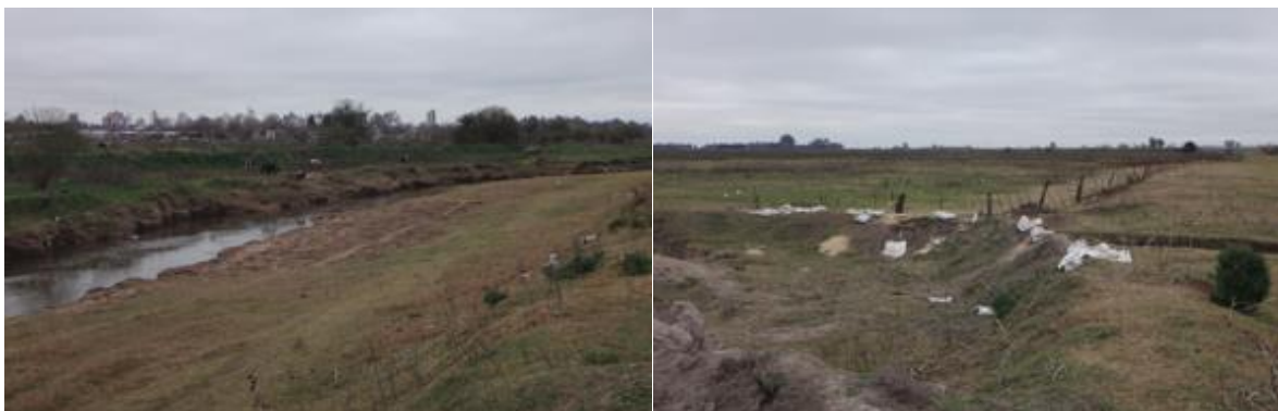
Terraplenes a nivelar en Barrio Belgrano II (Vista a Barrio Guemes) Terraplenes a nivelar en Barrio Belgrano II
