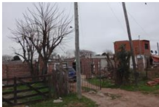
Viviendas con 2do piso en construcción, Barrio Belgrano I
