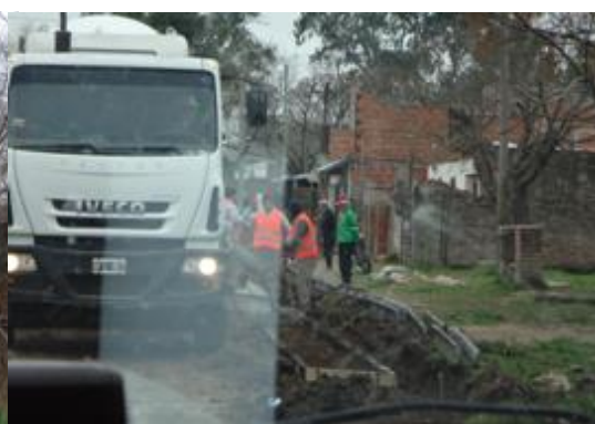
Ejecución de cordón – cuneta en Barrio J. Hernández
