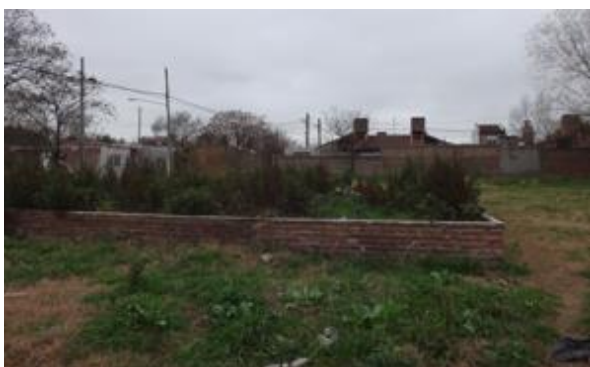
Construcción elevada abandonada, Barrio Belgrano I
